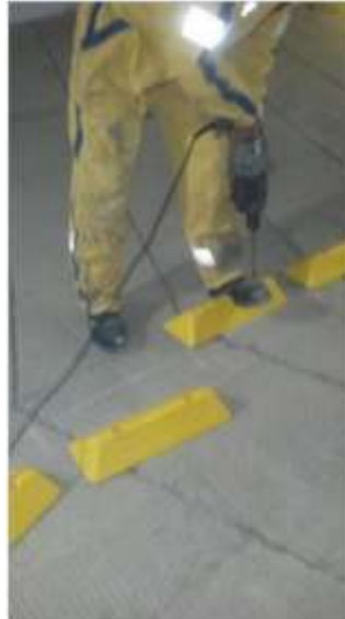
Gráfico 10. Instalación de bordillos traspasables
