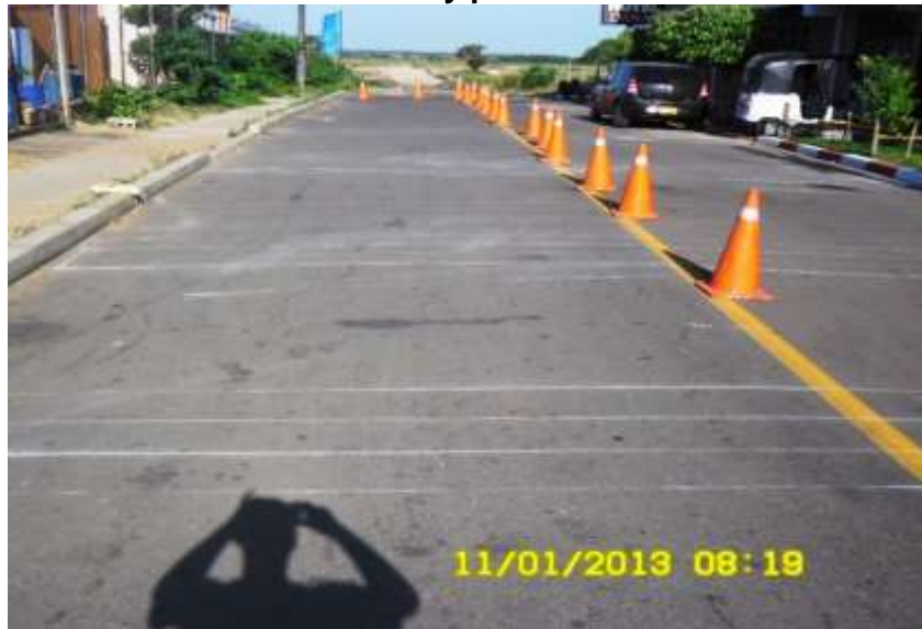
Gráfico 23. Localización y pre-marcado marcas viales
