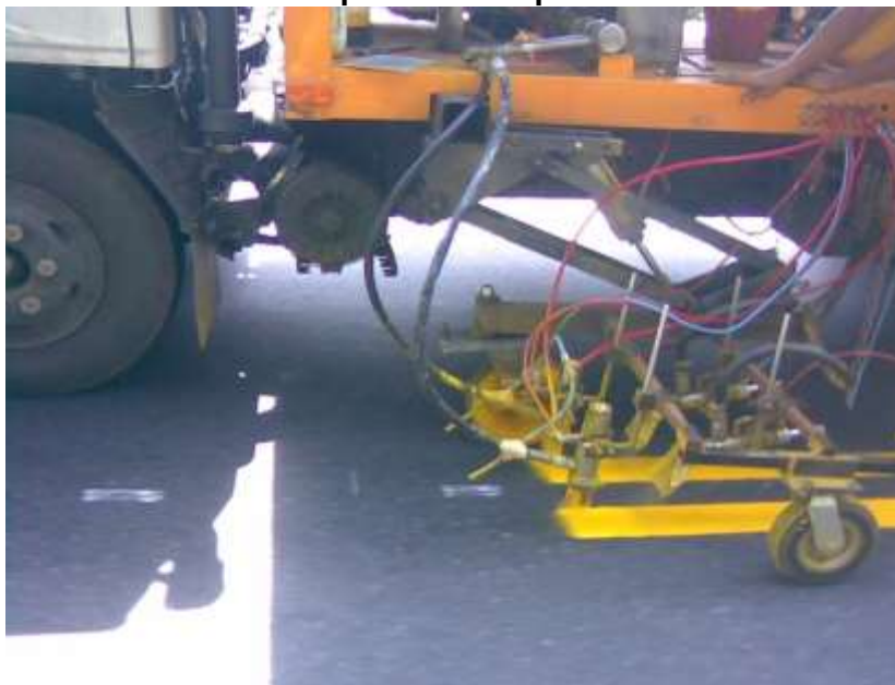
Gráfico 16. Aplicación de pintura Acrílica
