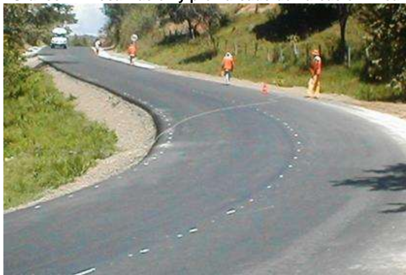
Gráfico 24. Localización y pre-marcado demarcación lineal
