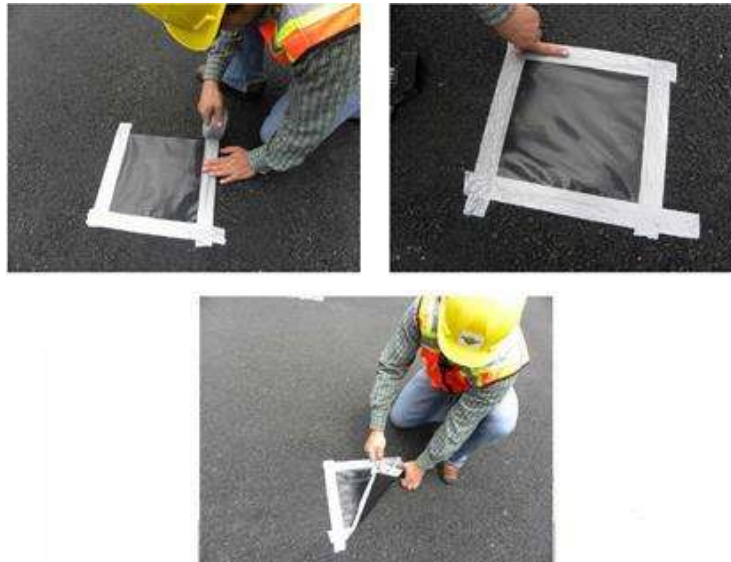
Gráfico 22. Prueba de humedad
